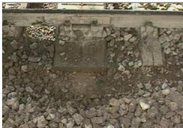
Abbildung 9: Spritzstelle unter einem Stoß (Foto Veit) 23
