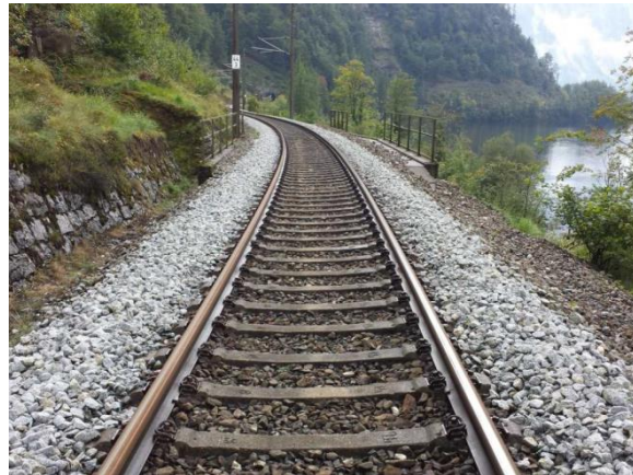
Abb. 39: K1 Schwelle unbesohlt bei Hallstatt in km 44,330 91
