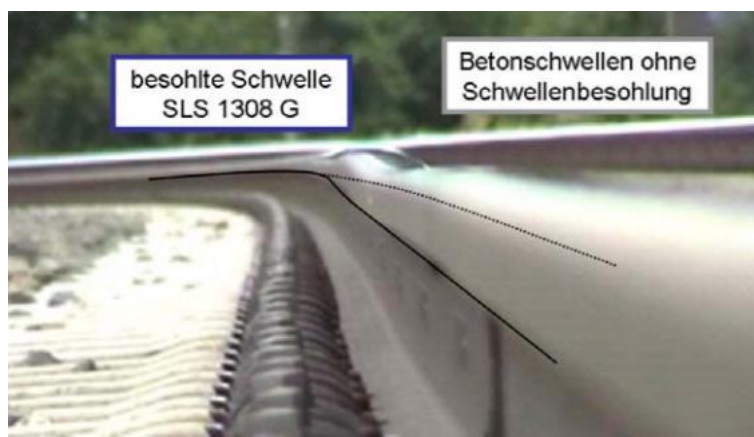
Abbildung 18: Übergangsbereich Betonschwellen mit und ohne Besohlung 70
