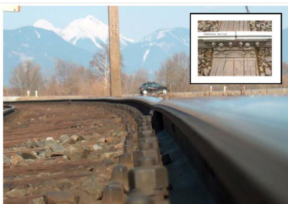
Abbildung 8: Schienenstöße sind Unstetigkeitsstellen 22
