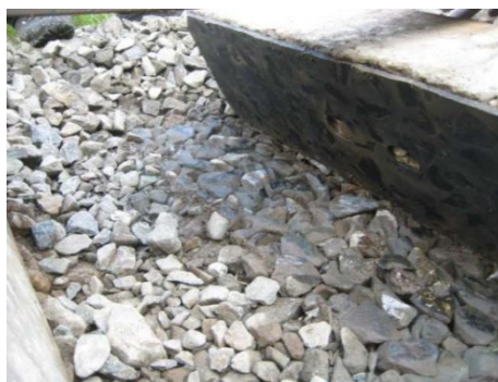
Abbildung 7: Schonung des Schotterbettes durch den Einsatz von Schwellenbesohlungen 15
