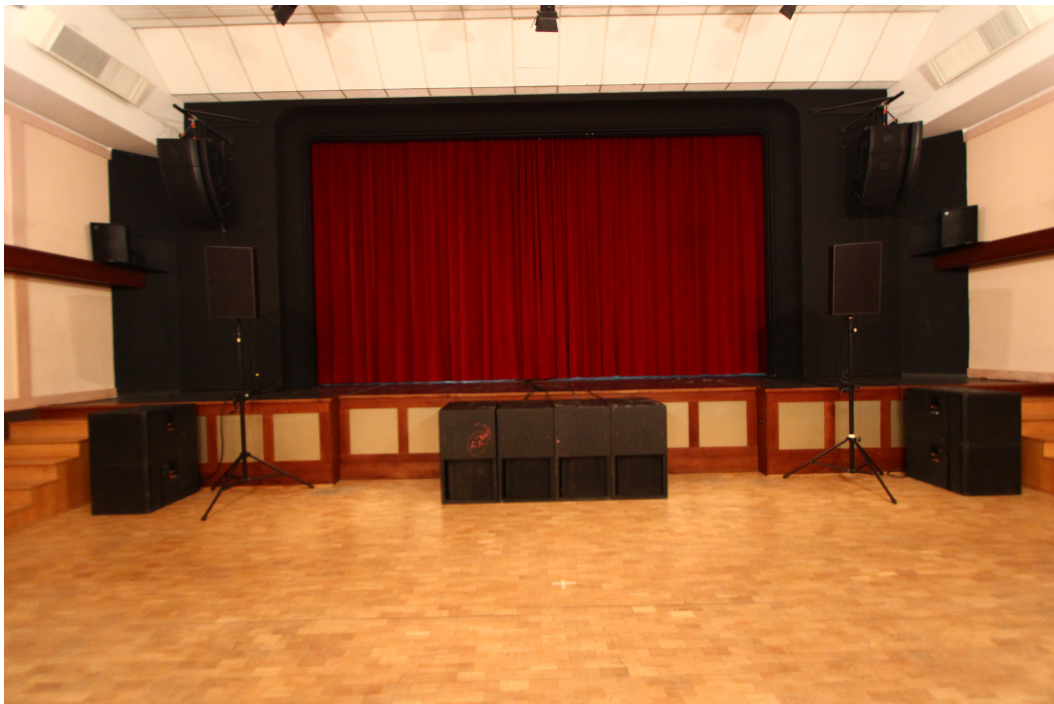
Abbildung 36. Positionierung Lambda Labs Systems (Mitte) und des VRX Systems (aussen) im Stadttheater Bruck an der Leitha.
