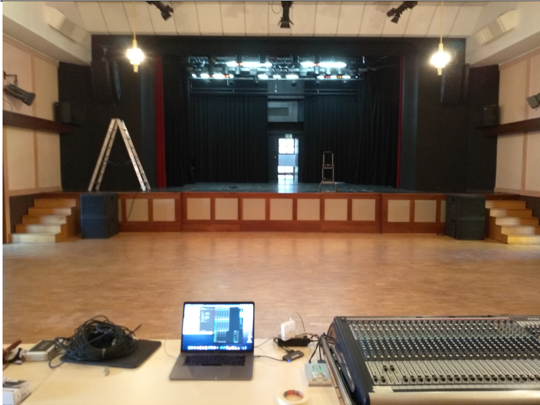
Abbildung 33. Positionierung des JBL VRX Systems, inklusive der dazu empfohlenen Subbässe im Stadttheater Bruck an der Leitha.
